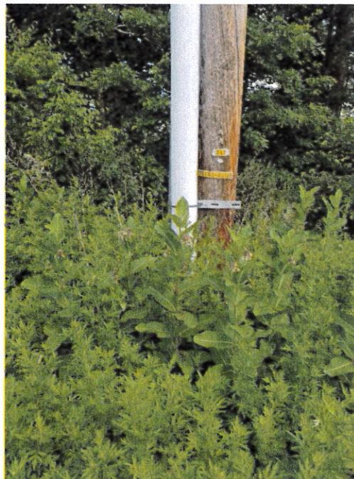
HS North Main Data Center Conduits
